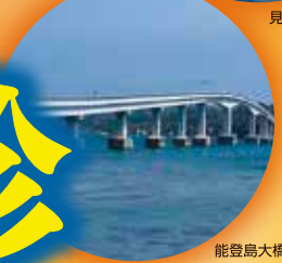
能登島大橋 [七尾市]
